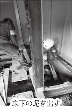
床下の泥を出す
